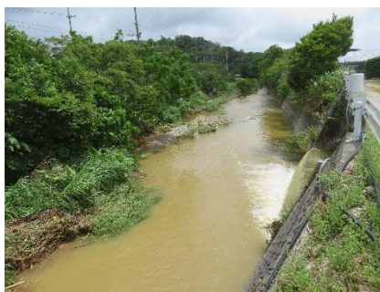
大井川 新呉我山橋 下流 11:05
